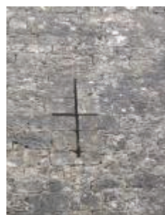
Demeure. Tour, élévation ouest, détail : archère du premier étage.
