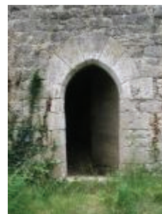
Demeure. Tour, élévation sud, détail : porte du rez-de-chaussée.
