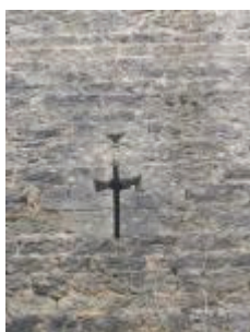
Demeure. Tour, élévation sud, détail : archère placée au-dessus de l'évier.
