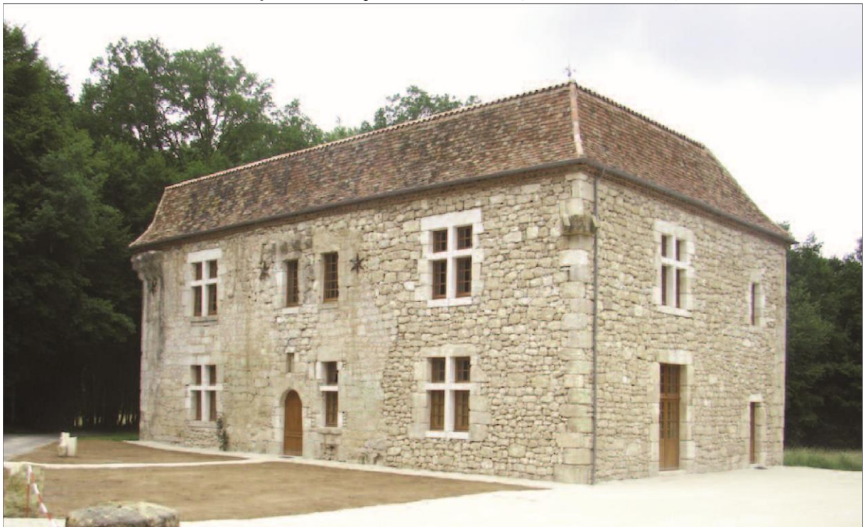
Figure 3 - Vue générale de la maison forte de La Roque à Marsalès en cours de restauration. (© Cliché J.-M. Baras, 2017).
