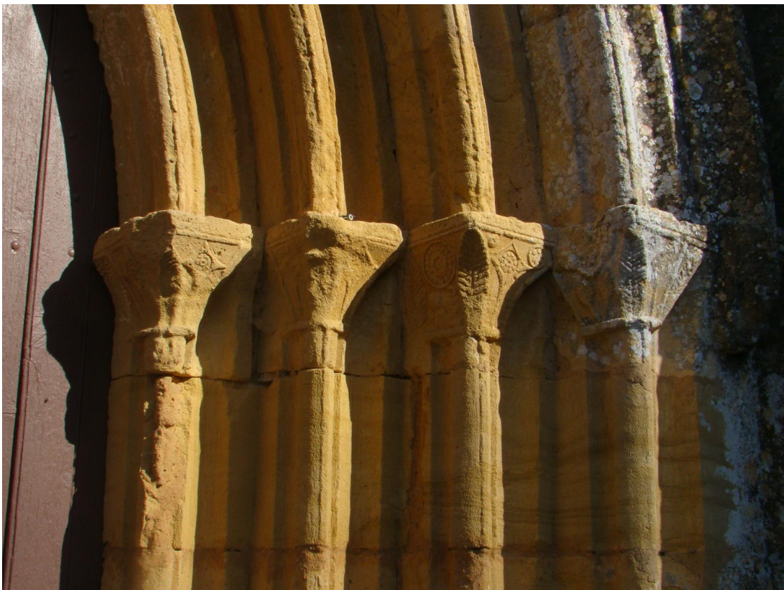
Les 4 voussoirs du portail (Photos J-M. Baras)
