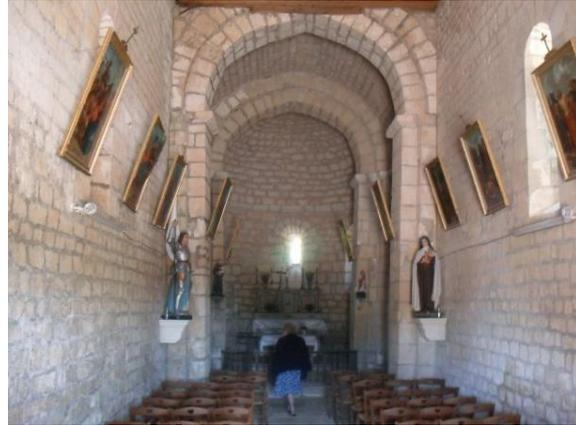
Les murs sont construits en un moyen appareil régulier de calcaire ocre, de provenance locale.
